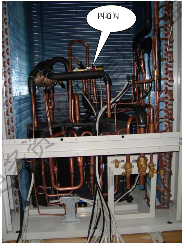
图 9：CMV-[V]直流变频模块式多联机四通阀位置示意图
