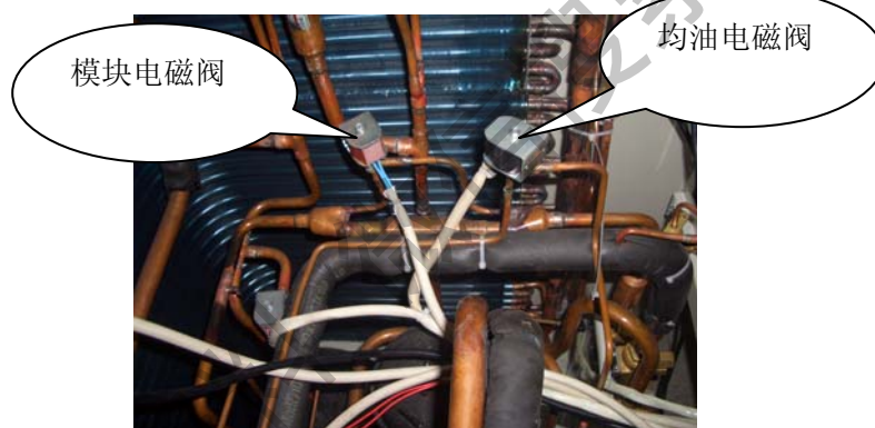
图 21：模块电磁阀位置示意图
