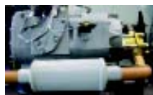
排气管路消音器
