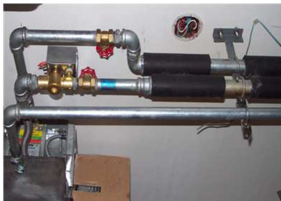
电动二通阀安装实例
