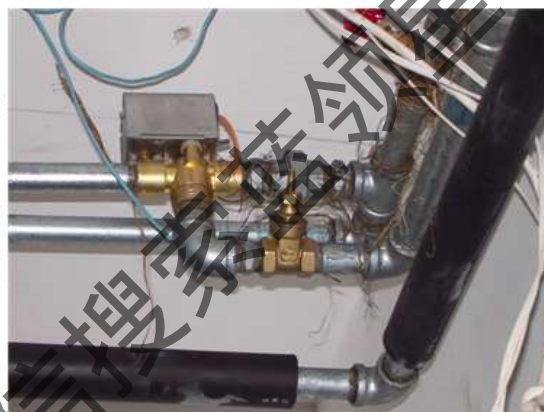
电动三通阀安装实例
