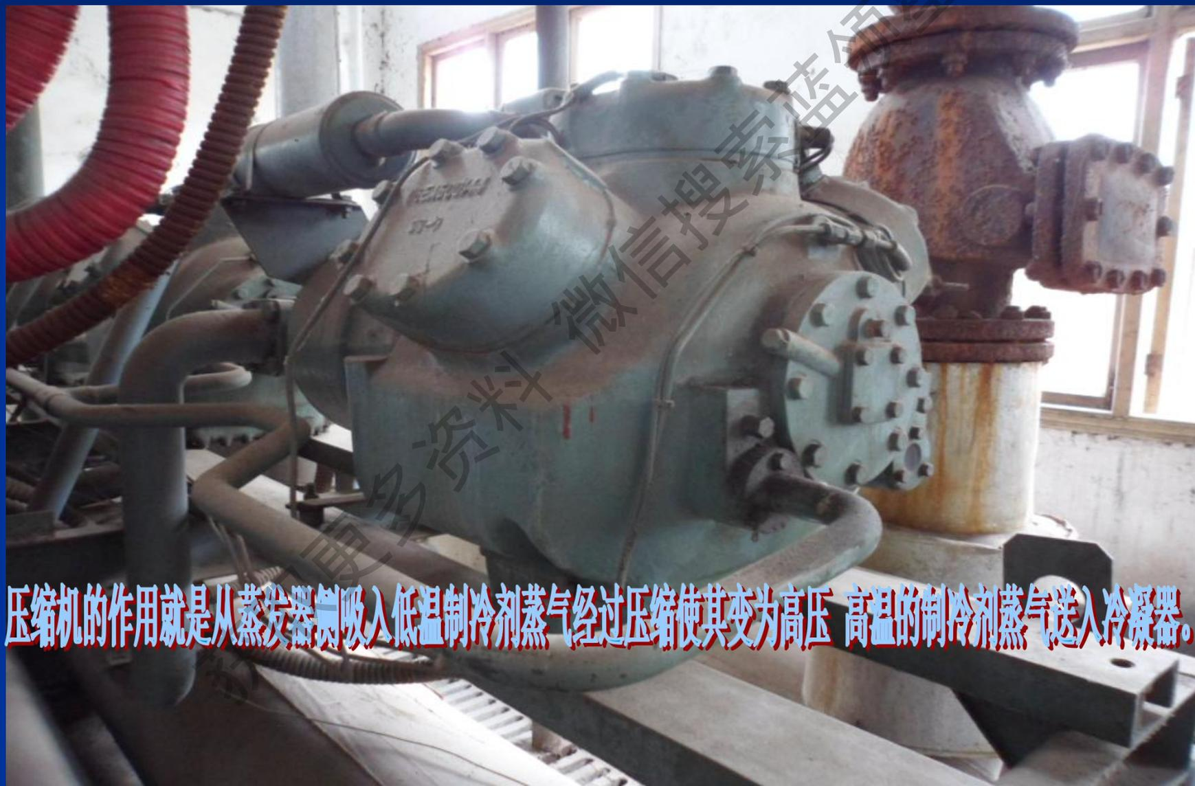
压缩机的作用就是从蒸发器吸入低温制冷剂蒸气经过压缩使其变为高压 高温的制冷剂蒸气送入冷凝器。
