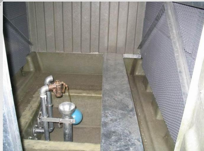
一般的横流冷却塔内部走道结构
