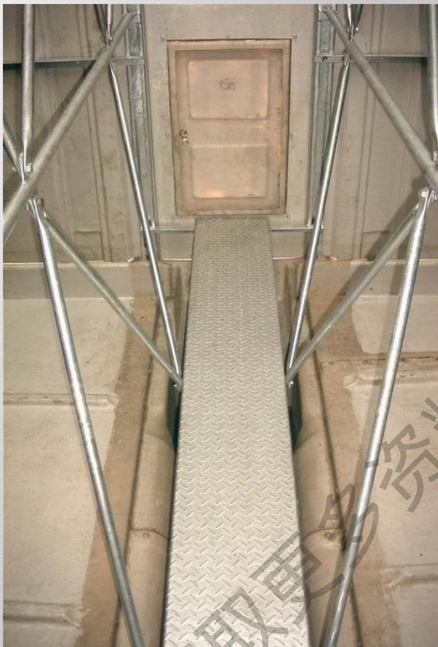
塔体内部设有维修走道及护栏，保障日常维护、维修人员的安全。
