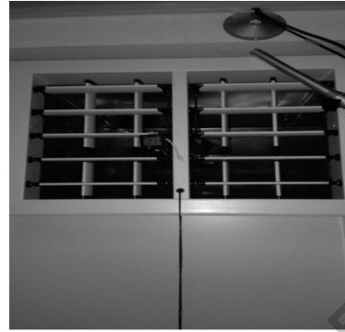
图 7 送风口测点布置图 Fig. 7 Design of air outlet
