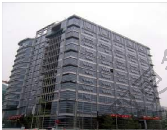
北京人民保险办公楼 30HXC300TR*3台
