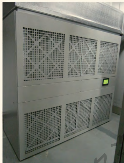
(a) 热管热交换器室内机
