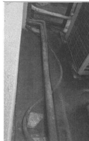
图7 冷媒管被冰雪淹没
