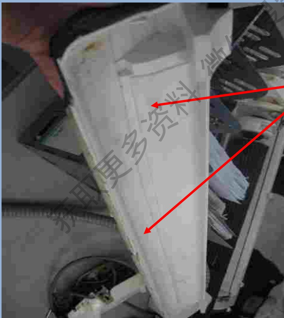
箭头所指向位置贴了两条PE棉，当水槽内积满水时，PE棉被水泡松，而失去保温性能，在出风主体的另一面产生凝露
