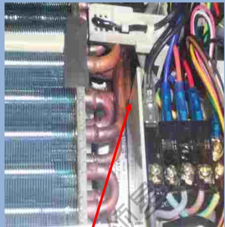
蒸发器高低压管保温套套过头，与蒸发器小弯头相触，小弯头的冷凝水顺着保温管流出而产生滴水。
