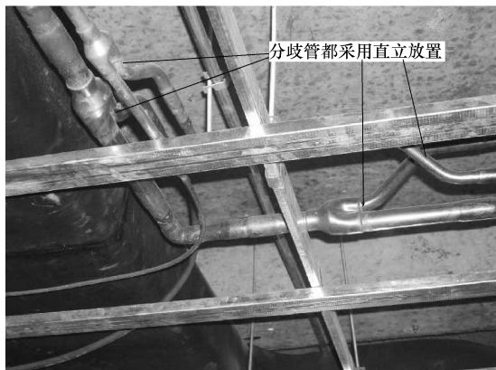
图 3-66 分歧管水平安装角度错误示意图 1
