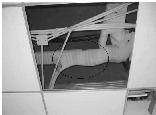
图 3-72 分岐管出管直线段距离过短示意图
