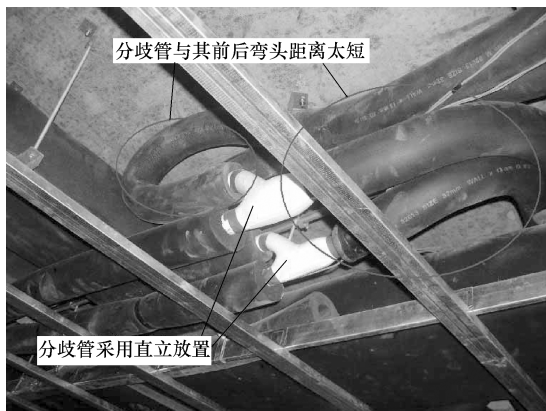
图 3-68 分岐管安装时折弯距离过近示意图
