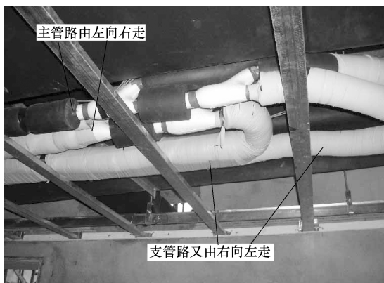
图 3-70 分岐管安装时走向过于复杂示意图
