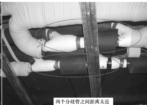
图 3-69 两个分岐管安装时间隔距离过近示意图
