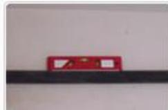
冷凝水管从内机接出后至室外或地漏，至少保持 $>1\%$ 的坡度
