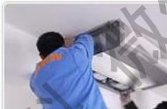
内机吊装需考虑千分之五的坡度，接冷凝水的一侧要稍低，便于冷凝水排出
