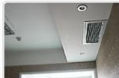
一般把回风口和检修口开在一起，预留检修空间。装好后开启空调，检查回风温度、送风温度、电流等是否正常。
