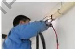
焊接时采用充氮焊接工艺，焊接完成后应该用高压氮气进行管内吹灰
