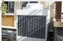
外机风扇出风口必须在50公分内外机后部15公分之内无遮挡物，所有落地脚必须安装减震垫
