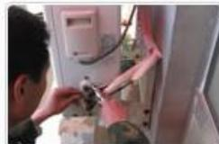
开启冷媒阀，释放出外机自带的冷媒，开机测试并检测压力，适当进行补充，直至调试完成
