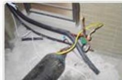
焊接完成后对铜管进行充氮保压测试，压力测试时间为24小时
