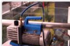
冷媒管抽真空以确保系统干燥，避免发生冰堵、电气绝缘破坏等情况
