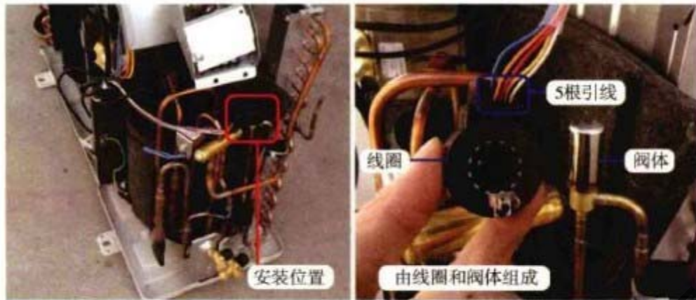
图 2-4 电子膨胀阀
