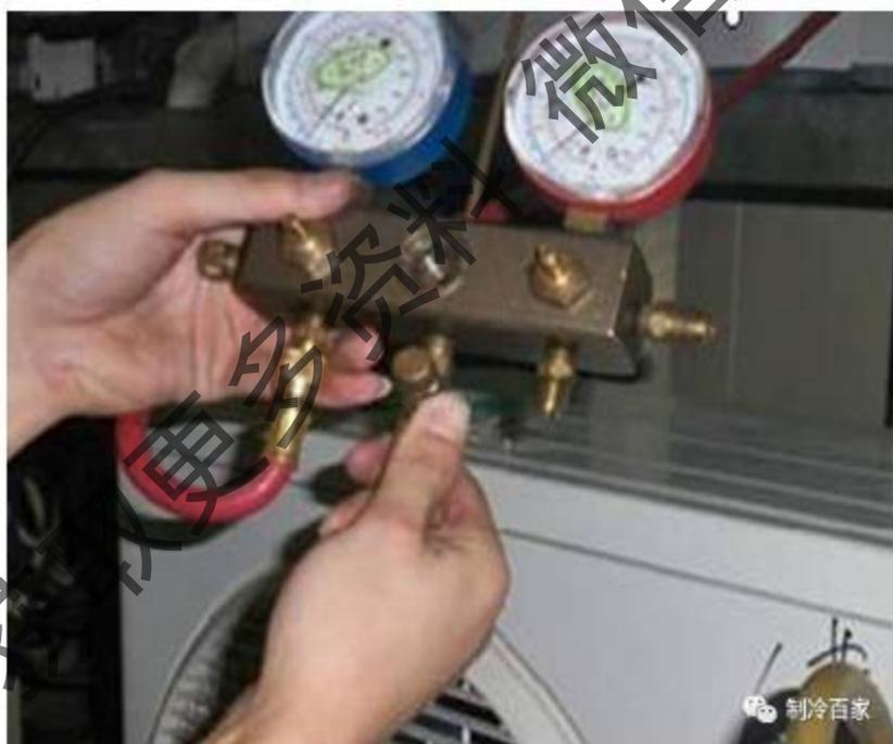
4、变频空调加冷媒要将空调设置为制冷 P1 模式下运行，控制好冷媒罐的开度，根据压力对
