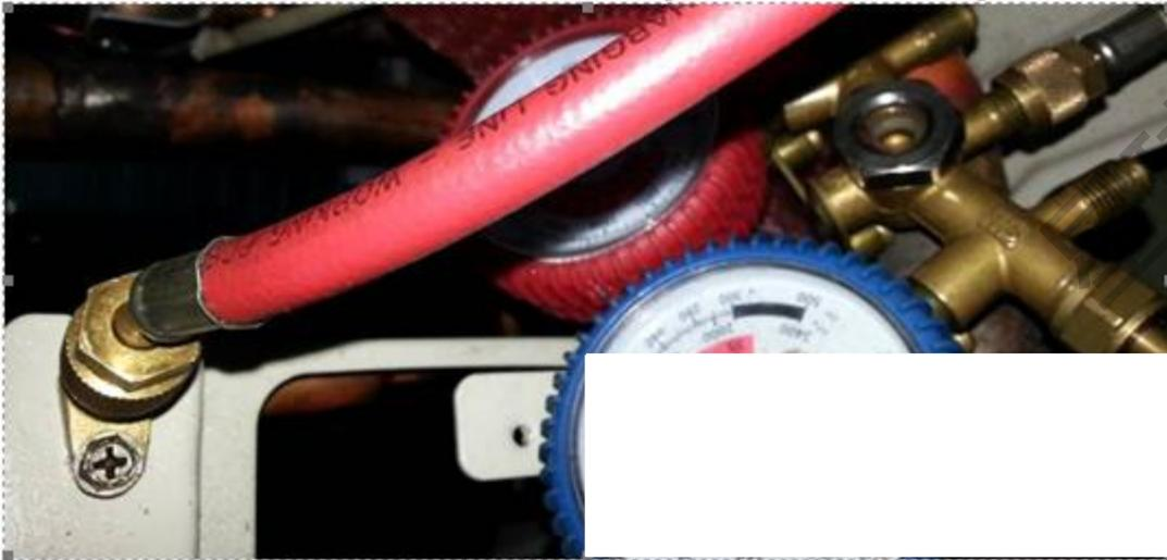
解决方案：如果实测的压力为正常则进行第三步的检查，如果实测的压力已经到了 **0.08Mpa** 则进行第二步的检查
