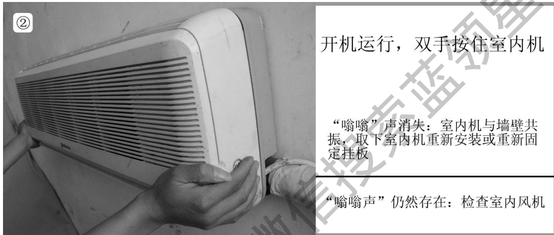
(b) 检查室内机安装位置
