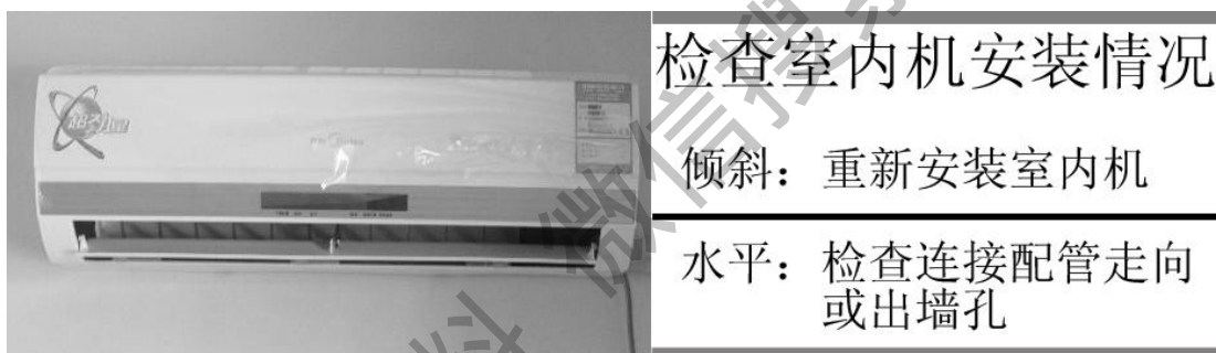
图 5-58 检查室内机安装是否水平
