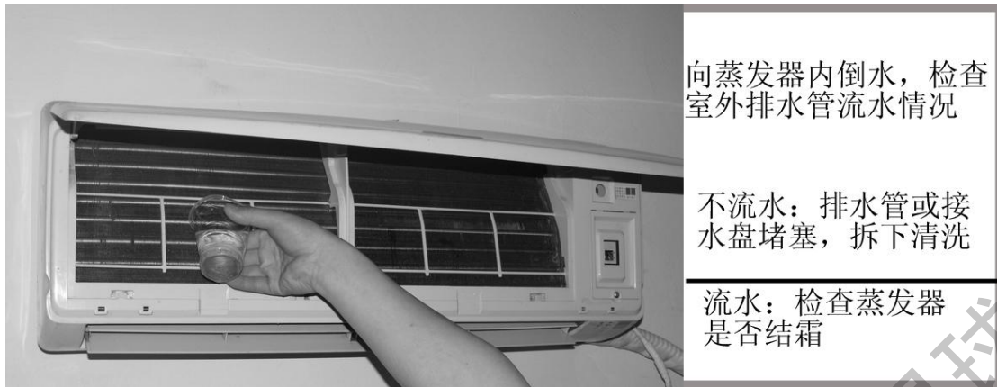
图 5-60 向蒸发器内倒水
