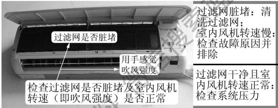
图 5-37 检查过滤网及室内风机运行速度
