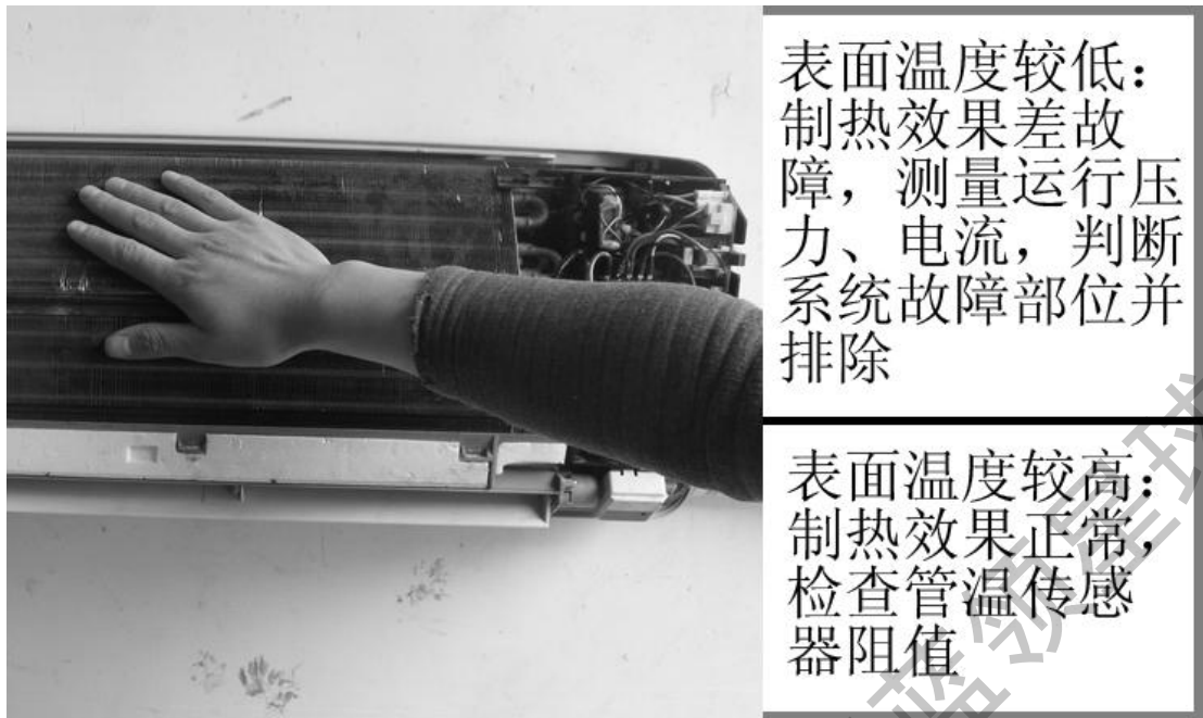
图 5-19 检查蒸发器表面温度
