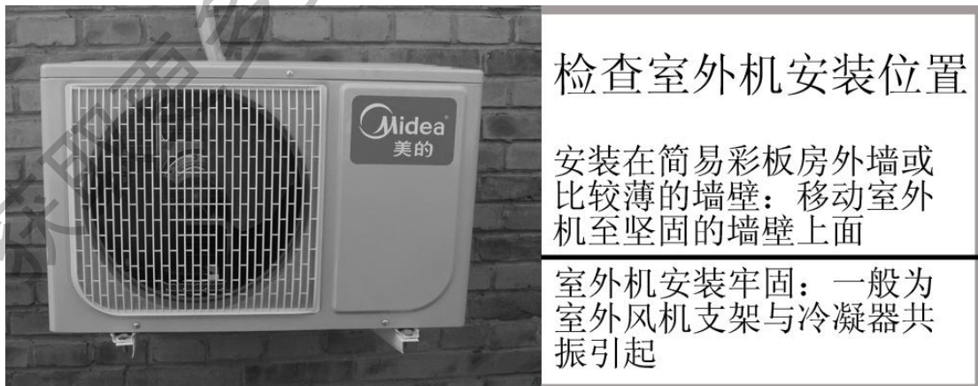
图 5-56 检查室外机安装位置
