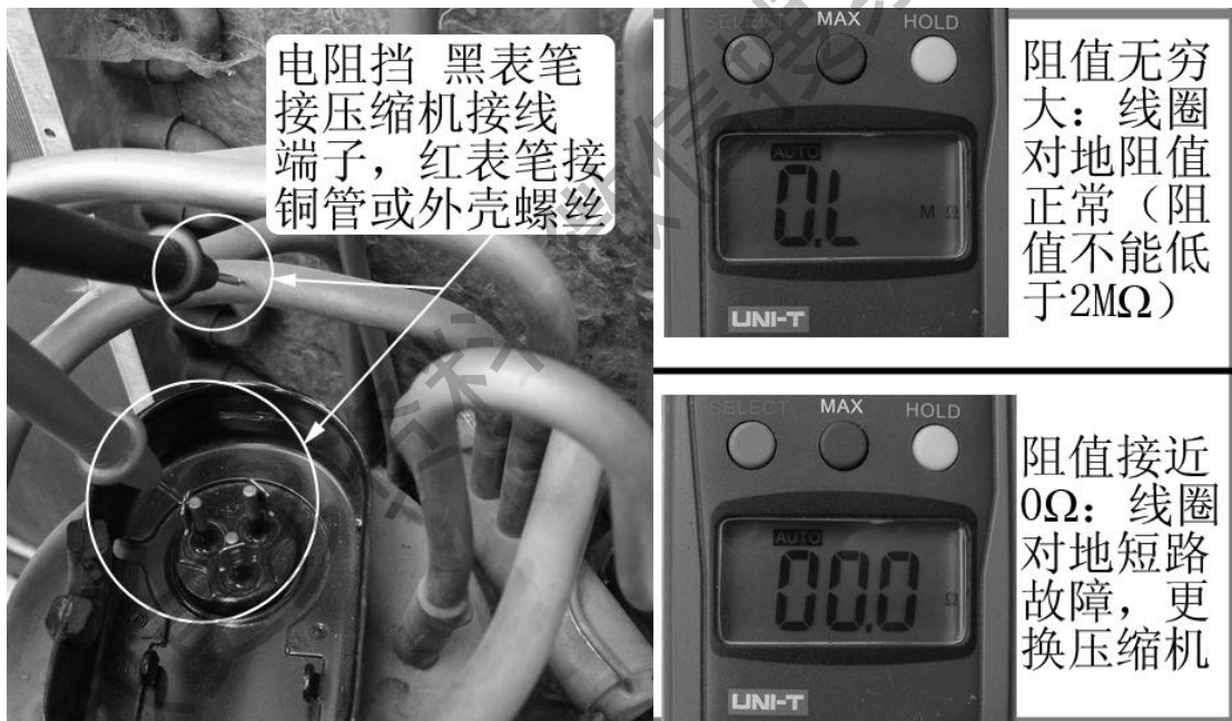
图 5-45 测量压缩机对地阻值
