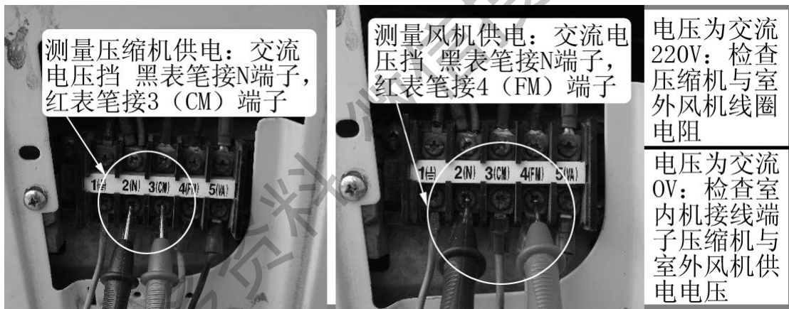
图 5-22 在室外机接线端子测量压缩机与室外风机供电电压
