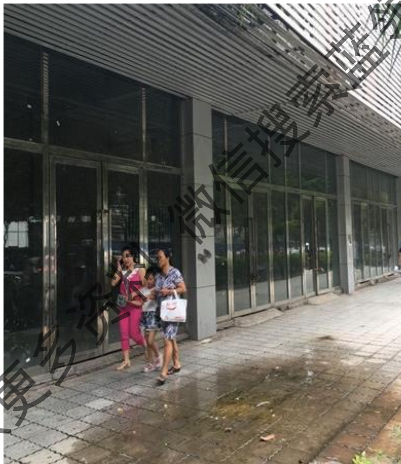
漏水空调外机扰行人
