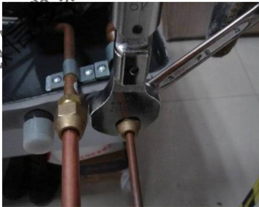
固定开口扳手卡紧管接头，另一扳手拧紧
