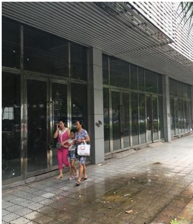
漏水空调外机扰行人
