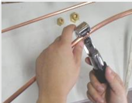
1. 用割刀切断配管
