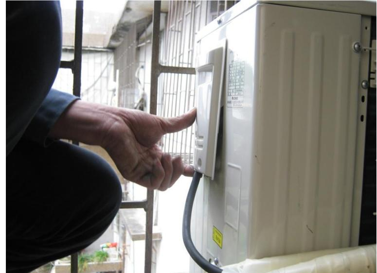
注意：将导线整理好露出一段即可，多余的导线放入室外机，盖上提手，拧紧螺丝。
