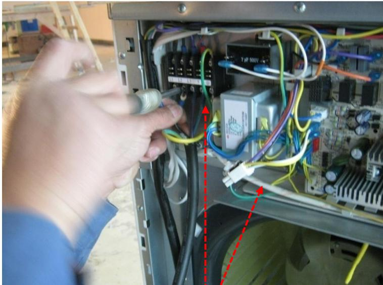
插入端子后压紧，对接好插接件
