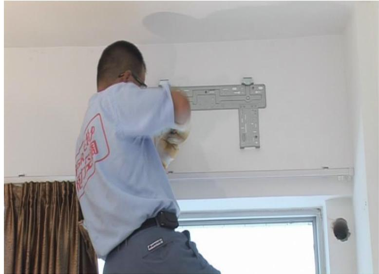
注意：钻孔时咨询用户墙内电路和水路的走向，避免触电。
