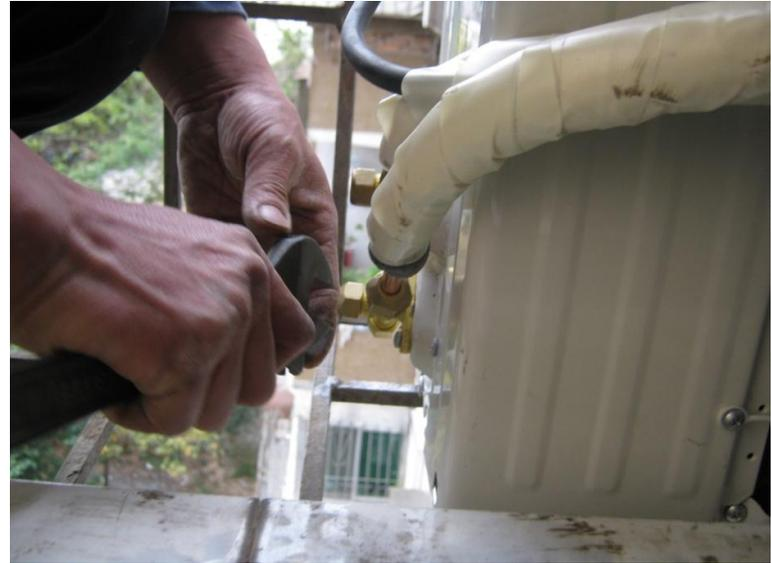
**注意：**抽真空完成之后，一定将所有的螺帽都装上，并用扳手拧紧以防止冷媒泄漏。
