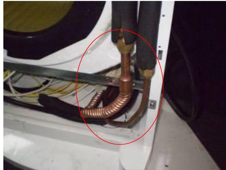
解决方法：①将室内部分吹塑排水管单独包扎保温棉后然后再包扎；
