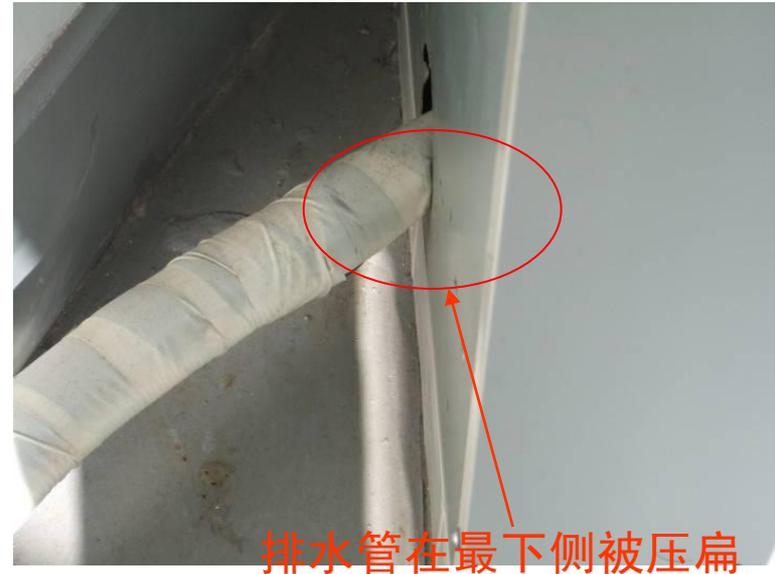
解决方法：①如上左图所示后直出管折弯部分可以将折角调大同时在折弯处多缠几圈胶带以增加其强度；
