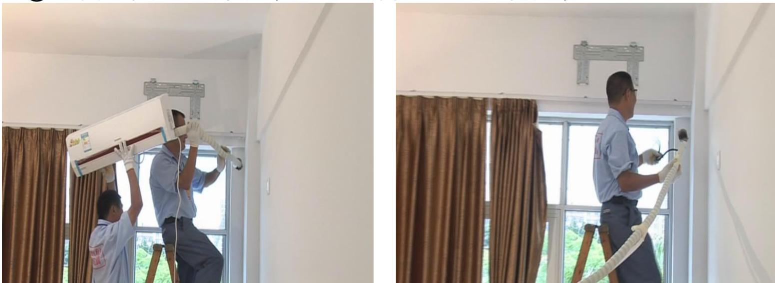
注意：穿墙时铜管堵头不要拿掉，避免穿墙时灰尘落入
