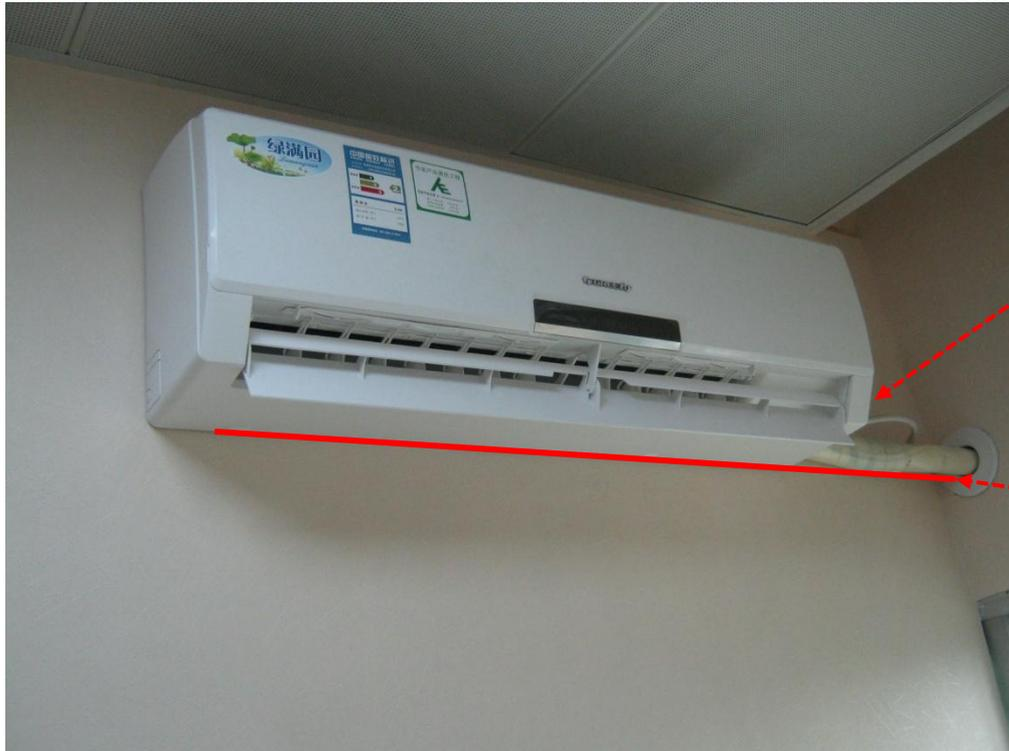
将多余电线放入底壳后的虚位中
