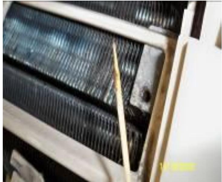
解决方法：①清洗蒸发器，清洗过滤网，清洁排水管；
