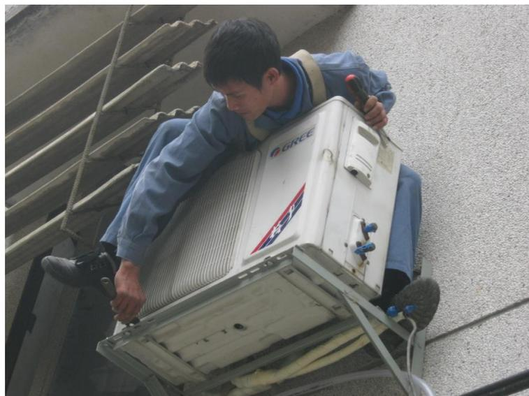
注意：吊装室外机注意高空作业安全，两米以上高空必须佩带安全绳，安全绳需固定在可靠的固体上，确保有足够的安全措施才能操作。
