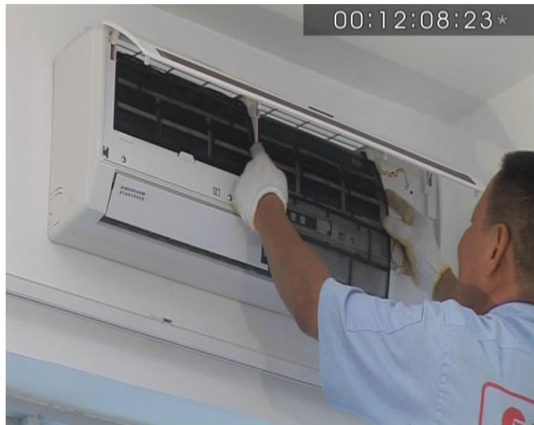
注意：将拆下的过滤网轻轻拍打一下再用刷子在水中（水温不要超过40°）刷一下，如果特别脏，可以使用中性洗洁剂。
