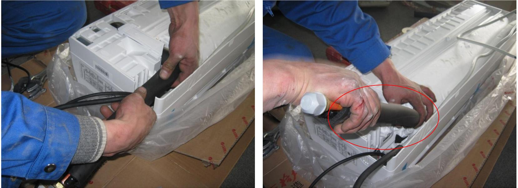
注意：①敲落孔开口处不能有毛刺，避免划破包扎带及管路；
