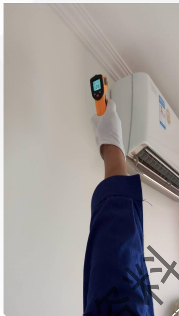
进风温度检测
