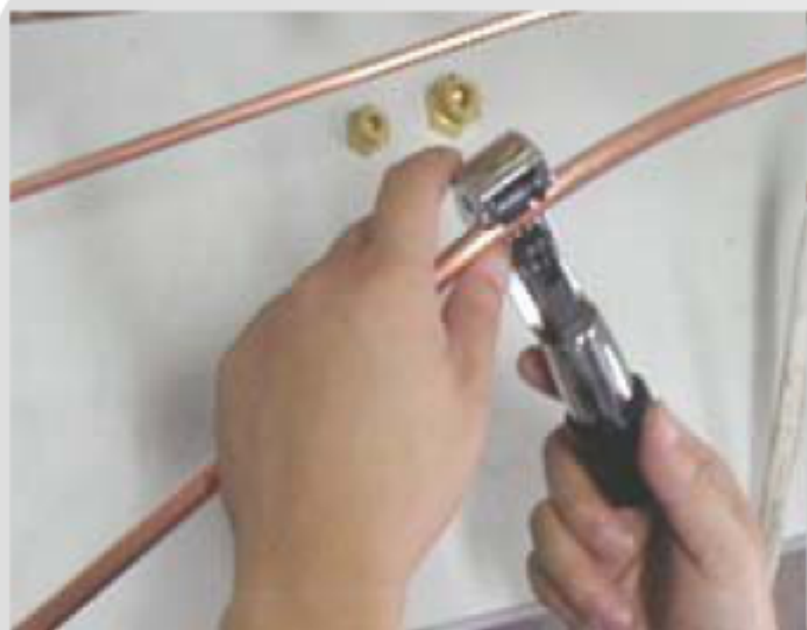
1. 用割刀切断配管
