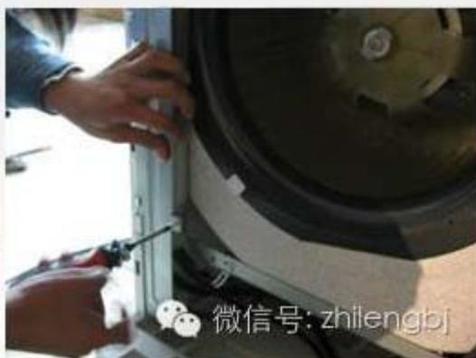
注意：1、接线完毕后，盖好电器盒盖和过线槽盖后用螺钉拧紧；
