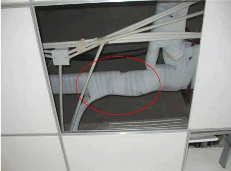
在对部分工程安装进行抽查时，我们发现此问题：分歧管分出的管路没有保留一定的直管段，而是分出后立即折弯，这对此分歧管后的室内机组将产生很大影响。
