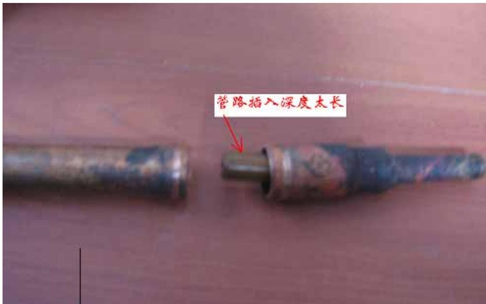
5、分歧管的焊接在实际工程维修中，我们发现一套 12 台多联室内机最后两台 A 和 B，当 A 开时，B 的制冷效果就差，A 要不开，则 B 就好，于是我们将最后一个分歧管连同连接 B 的管路全取下，并割开可疑管路发现左图示状况，经缩短插入深度处理后，机组运行正常。
