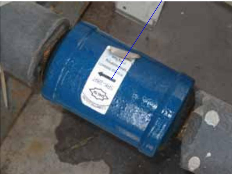
此台机组是数码 300 热泵机组，但其安装的是单向过滤器，这样在制冷时起作用了，但在制热时，那就起反作用了，原来制冷时积聚的杂质现在反向一冲就更容易发生堵塞了。所以单冷机选择单向过滤器，热泵机要一定选择双向的。
