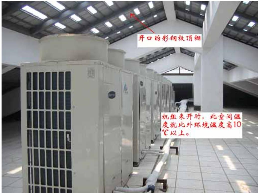
由于所有的室外机安装在半封闭的室内，所有机组采用出风口和回风隔开的做法，效果较好，能够有效的避免出回风短路的现象。（重庆投资大厦）
