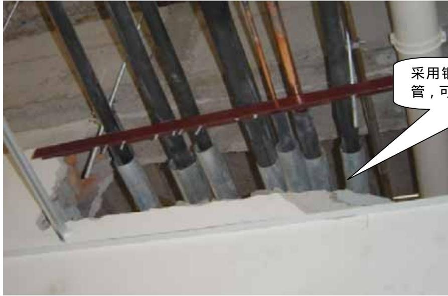
采用钢管作为管路的穿墙套管，可以保护铜管和保温层
