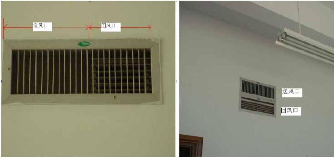
在实际工程中，由于空调设计人员对风管机的送回风缺乏认识，有很多机组设计成图示方式，这样也形成了机组送回风短流现象，使主机误认为房间温度已到要求，从而降低其能力输出，最后整个房间的制冷、制热效果就变差了。有时甚至还会对整个机组运行产生严重影响。
