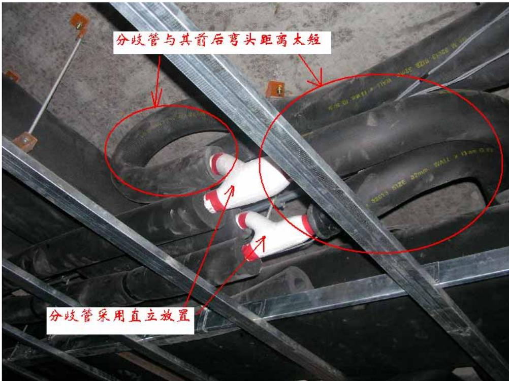
分岐管与其前后折弯处的距离太近，也将影响流经此处制冷剂的正常分流，使其下游的室内机制冷效果受到影响。所以必须要保证分岐管与其前后折弯处的距离在 500mm 以上。同样，两个弯头（折弯点）之间的距离也要保证在 500mm 以上；两分岐管也要按照同样原则进行安装（下图所示，安装的分歧管也不合格）
