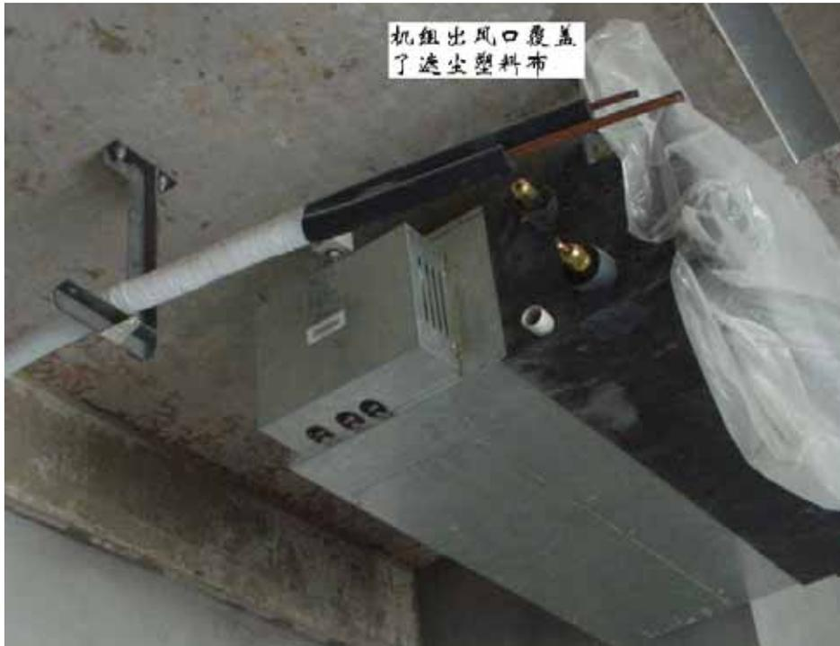
上图所示工程的室内机的出风口就覆盖了遮尘塑料布，但还有个问题，就是虽然风管机回风口有过滤网，但在实际工程中，回风口仍然是要覆盖遮尘塑料布。
