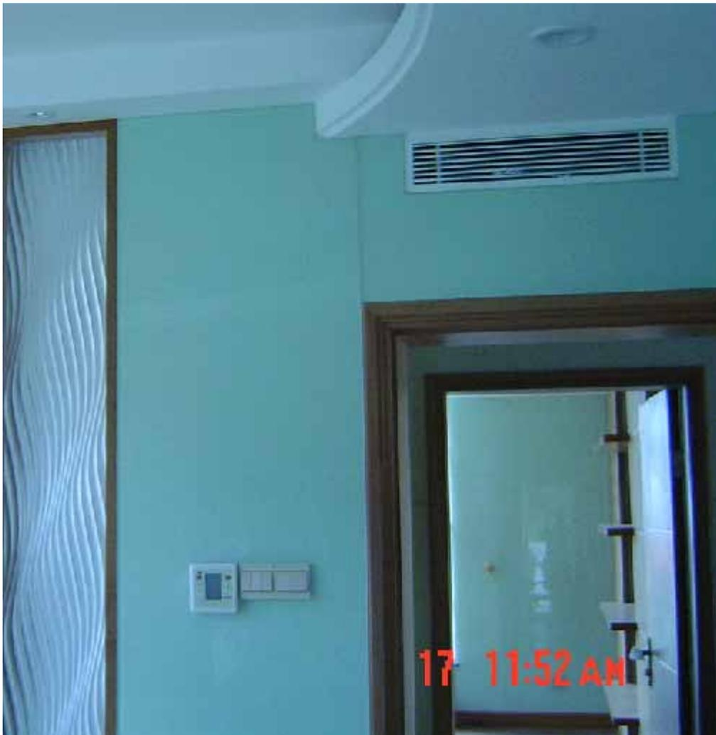
此工程实际选配的是高静压风管机，在实际运行中风声噪音太大，后也是经更换室内机风机电机，才解决问题。
