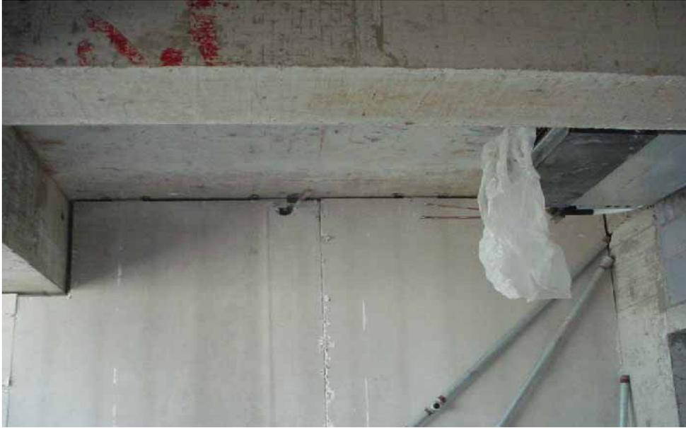
此工程的房型在高层建筑中具有一定代表性，房间中有加固梁，并且很厚（一般约 500mm）。如图示，此空调完全安装在两堵墙与两根加固梁围成的方格里了，室内机送出的风就会盘旋在此方格内，那整个房间的制冷、制热效果必然不好，并且还可能会对整套机组运行产生不良影响。
