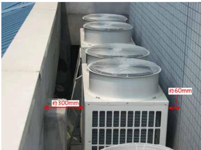
此处几台室外机放置在一个楼顶用彩钢板搭建的小棚里，机组未开时，由于彩钢板吸热，整个棚子里就象蒸炉，那机组在正常运行时如何进行正常的热交换？
