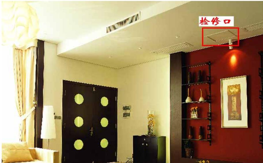
此工程在原来设计安装时没有检修口，后来又增加的。检修口设计原则以方便维修人员进行维修操作为准，售后人员可方便检查电器盒里的电元器件和检查机体里的电子膨胀阀，其位置一般要求在电器盒和连接管的下方偏外侧，其尺寸规格一般为 600mm × 600mm。
