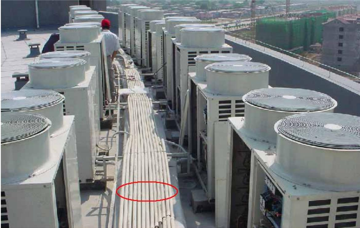
我们知道，当通讯线距离电源线较近时，电源线会对机组的正常通讯产生干扰。此工程中，电源线就和通讯线缠绕在一起，导致机组运行很不正常，后将二者分开一定距离（约 10cm，按照我们的要求是 15cm），机组运行就恢复正常了。
