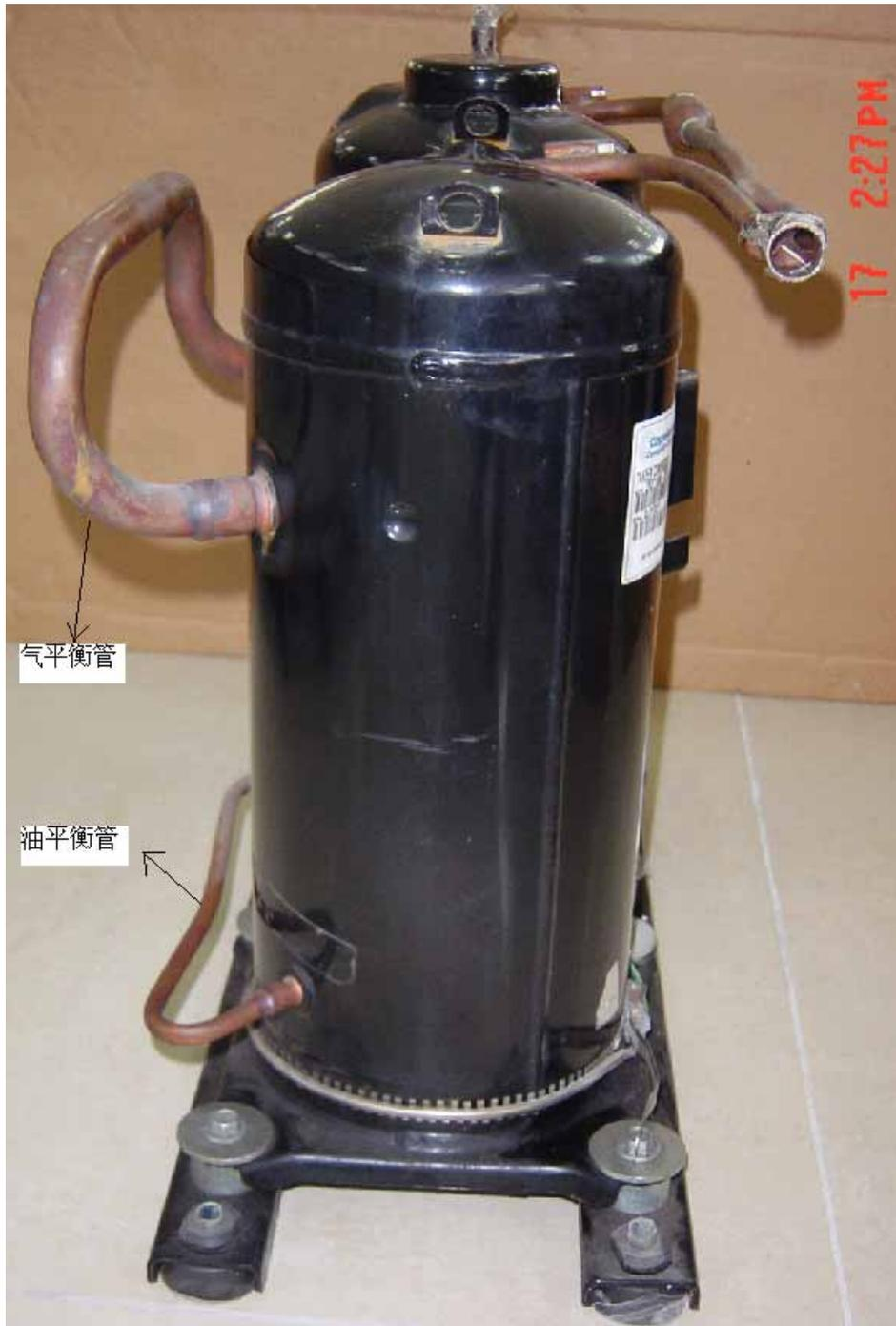
新替换的压缩机要放置到压缩机支架上固定好。为避免焊接使润滑油炭化，要先将压缩机倾斜一段时间后，再拔掉油平衡口橡皮塞；
