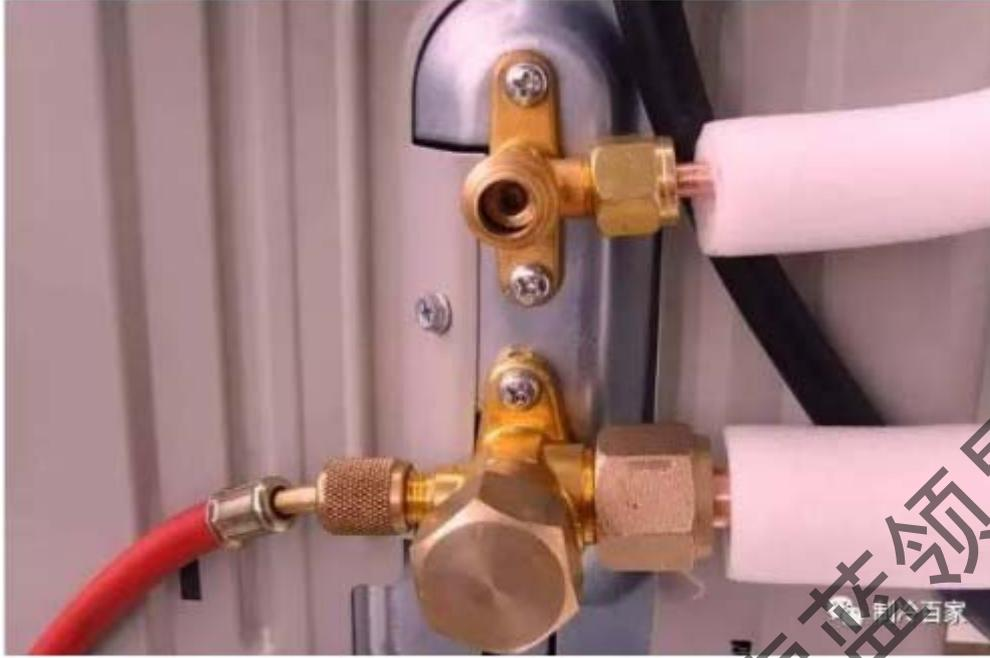
内六角扳手用来打开液管阀（细管二通阀 1 / 4 圈），10 秒后关闭。
