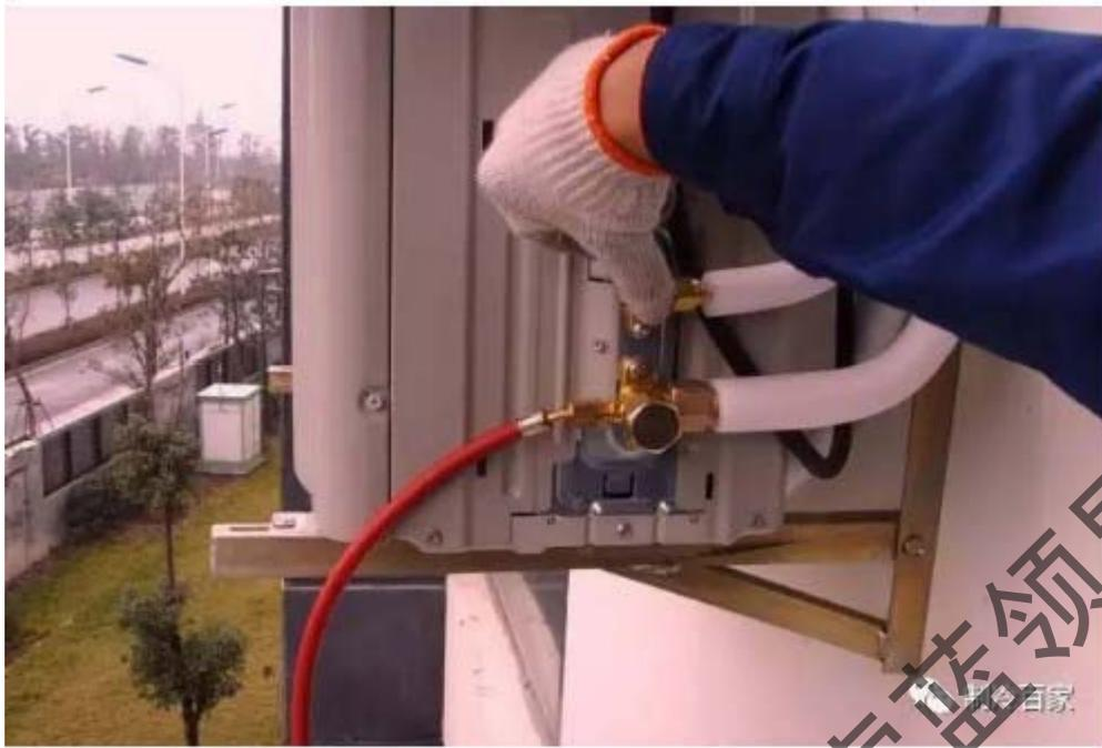
用检漏枪或者肥皂水检测接头等位置,确保没有泄露;
