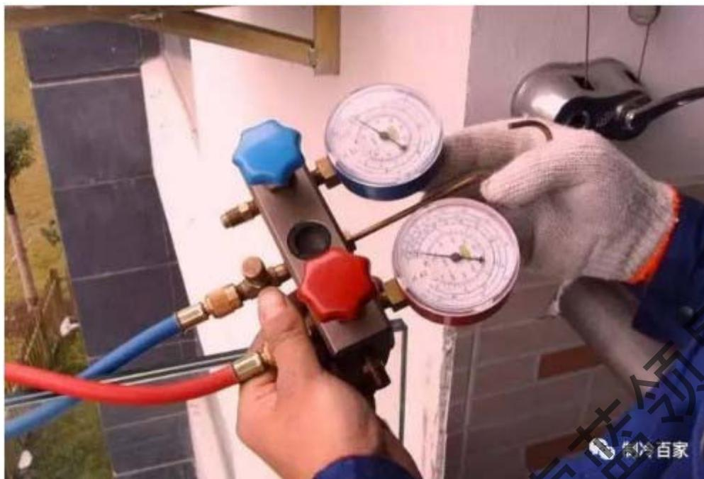
抽真空正式开始，一般来说是将压力抽置负 0.1MPA，再抽 15-20 分钟，以压力表负压值为准。
