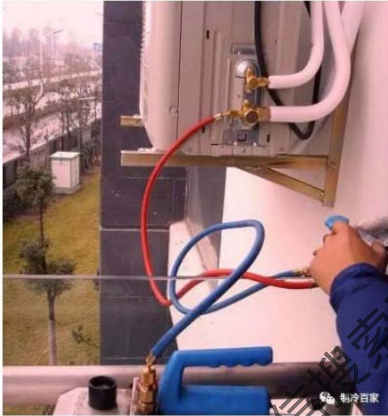
全部连接完毕，建议先开泵后打开压力表阀门，抽真空开始。
