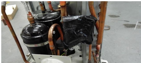
7、重新加液并装配，维修完成
