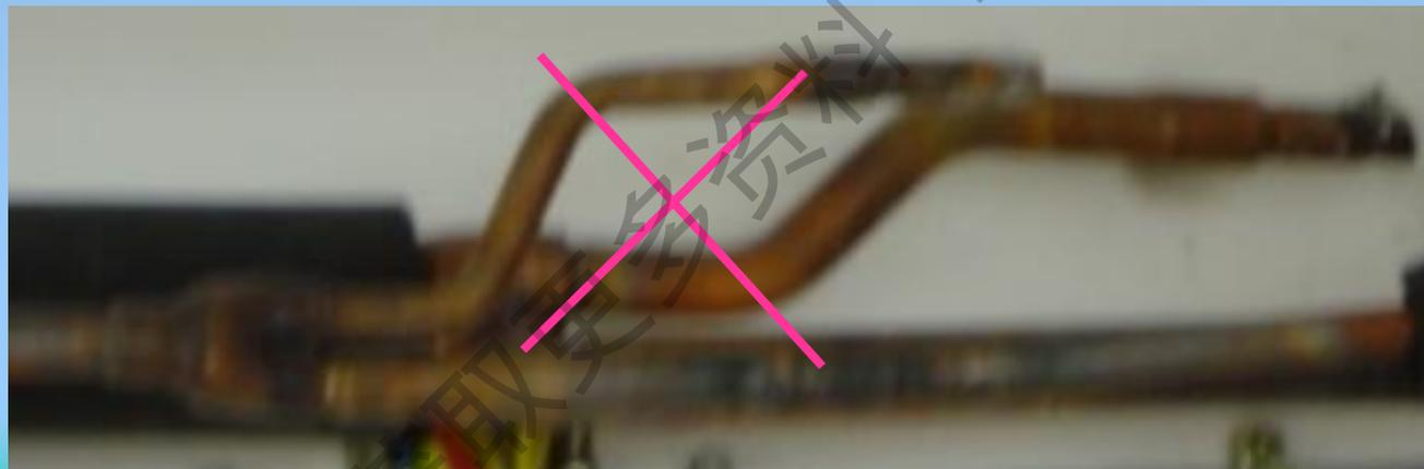
原因：垂直安装时，冷媒分配不均匀，室内机的制冷能力不能充分发挥
