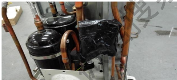
7、重新加液并装配，维修完成
