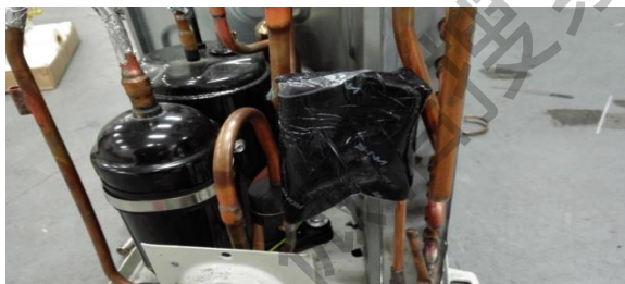
7、重新加液并装配，维修完成
