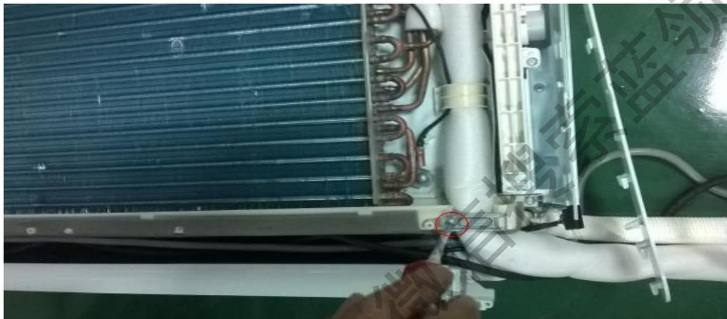
(2) 用手捏住管路压攀，从左侧向右推动管路压攀使管路压攀脱离固定扣
