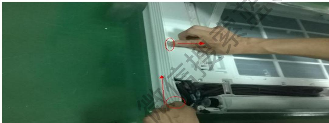
(2) 按下图中所示，向空调器内侧压住上部红圈中塑料扣，同时在下部红圈位置向上轻推右装饰板，右装饰板即可松开
