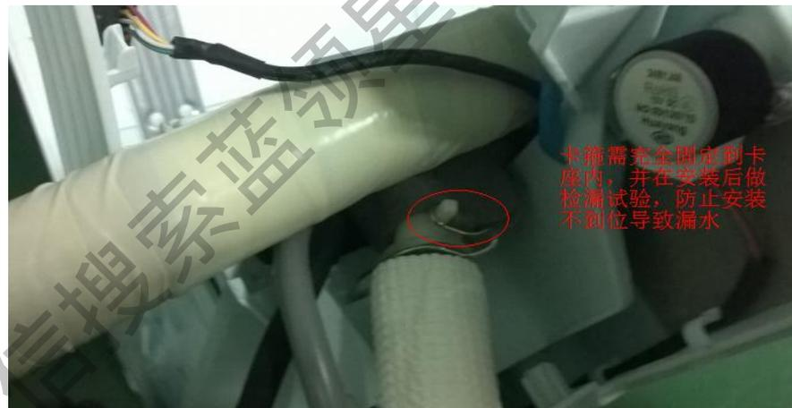
(5) 将内外机连接管、出水管捆绑固定到位后，用螺钉固定住下图中两个管路压板 **注意：捆扎连接管时须保证下图红色矩形部分的管路捆扎得尽可能细，防止安装时与下盖板干涉，影响外观间隙**
