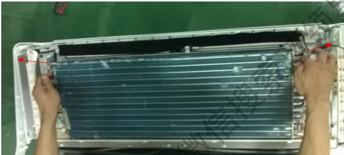
取下蒸发器后的内机如下图所示
