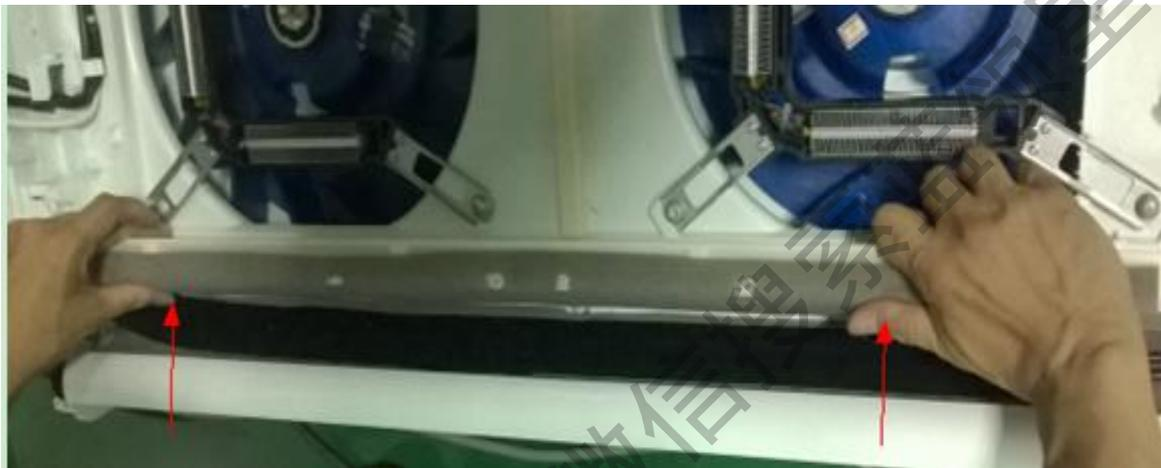
注意：安装集水槽时，须将集水槽中部突出部位对准中框中部缺口位置，再沿着拆集水槽时反向用力安装集水槽
