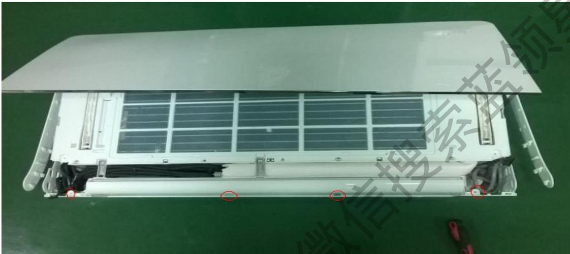
需确保安装好后的前侧板左右装配间隙良好
