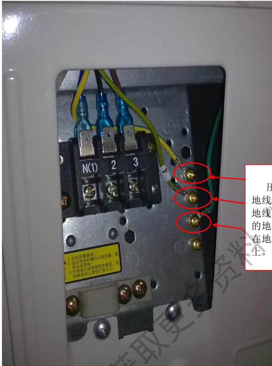
压缩机的地线，风机的地线，电器盒的地线单独打在地线螺钉孔上。
