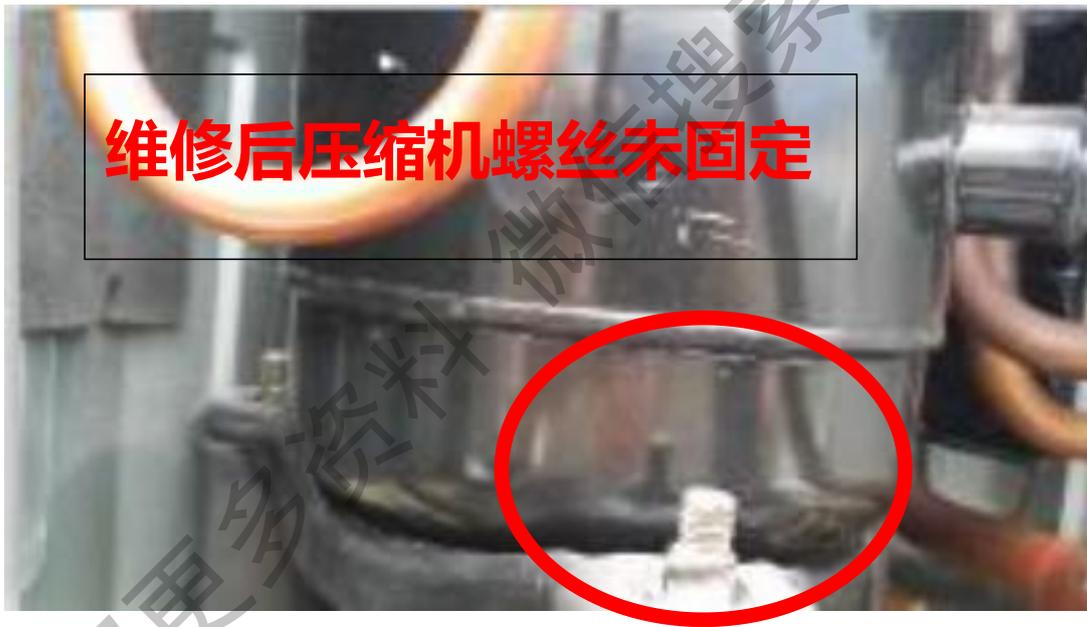
维修后压缩机螺丝未固定
