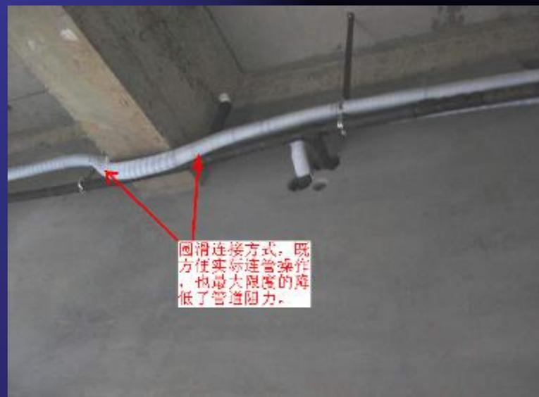
ii 制冷剂管道安装时要保证与机组电器盒的距离在300mm以上；管路不能挡住机组的回风口。
