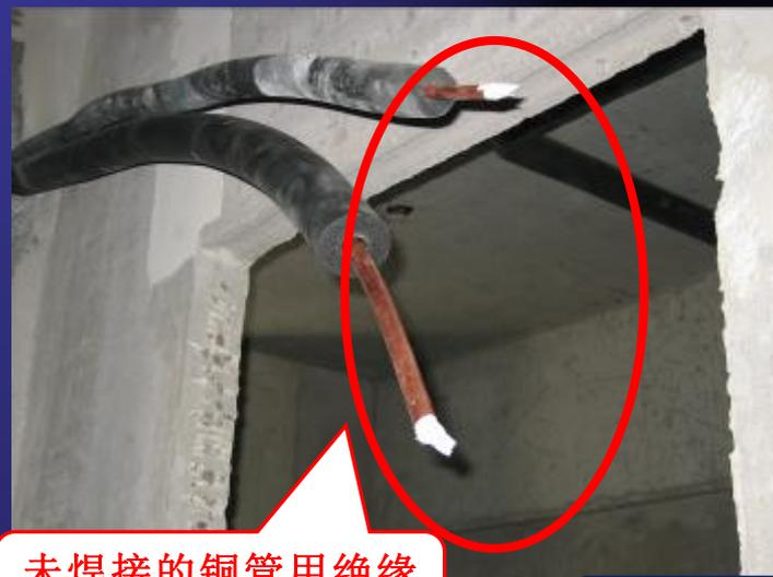
未焊接的铜管用绝缘胶带进行保护
