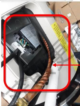
输出管为波纹管，波纹长度 18 厘米，弯管操非常方便。
