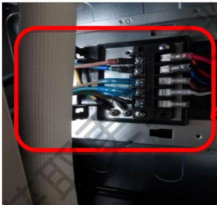
4)、依据电器盖板上的接线图进行接线，**特别注意：电线必须与接线端子固定牢固，固定螺钉不滑牙，否则将会导致打火，烧毁接线座。**
