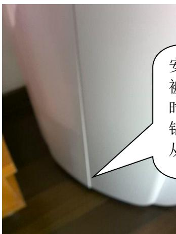
安装时开关门面板被扳动或拆卸过程中拿面板一端导致铝合金加强条变形从而产生错位。
