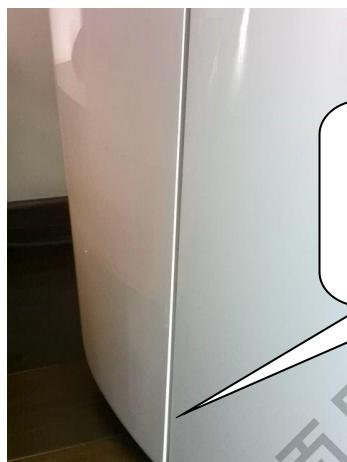
由于左图错位导致开关门无法闭合或缝隙大。
