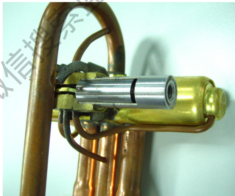
先导阀内部构造图片
