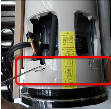
1)、确定好出管方向后再用尖嘴钳将相应的档块掰掉；
