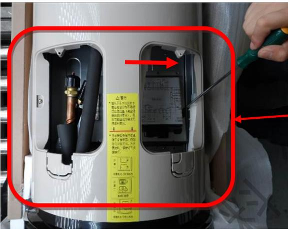
2)、拆下电器盖板固定螺钉，向箭头
