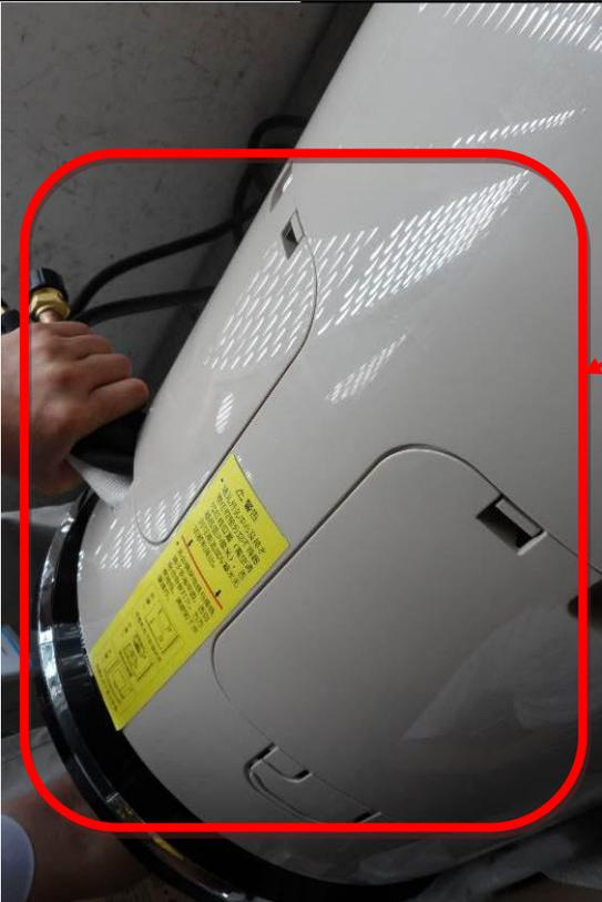
3)、检查输入输出管在机身内部是否都被保温管有效包裹，确认都包裹完好后，再将两个后盖板盖上并用螺钉固定；
