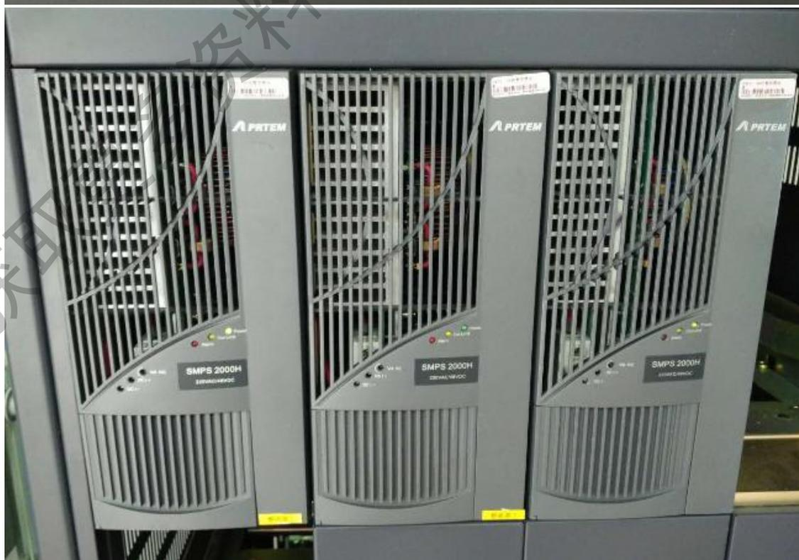
设置通信地址为 1，设置前进入“通信设置”，修改地址提示输入密码为“123456”
