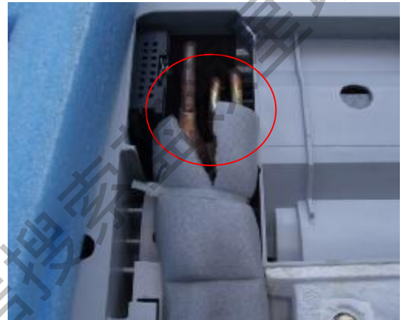
图 2.保温管开裂
