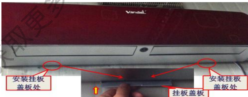
图 14(安装挂板盖板)
