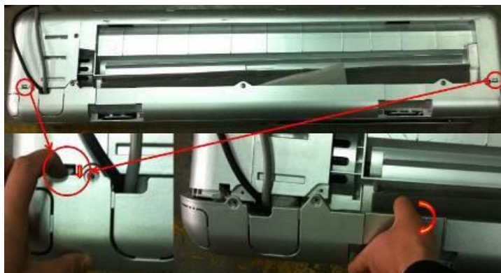
图 4(拆下底盘盖板)
