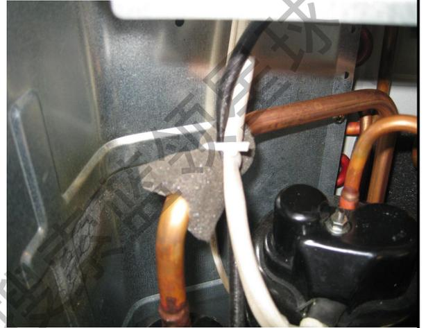
C、电加热带线体与压缩机线组在中隔板过线孔和其它线组一起用铁塑条扎紧（左图），而且和所有线组必须用束紧带扎好（右图）。
