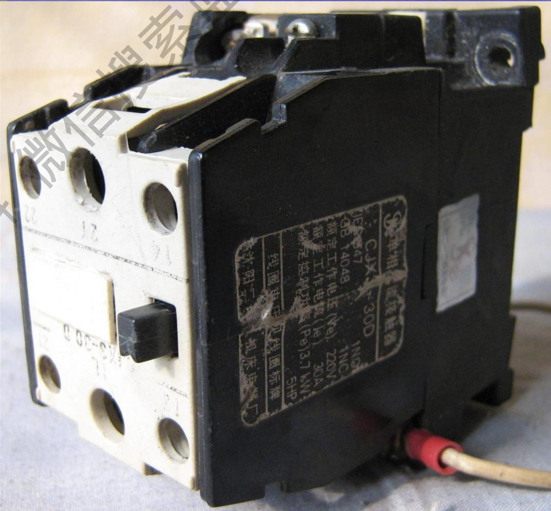
压机老是热保，打开外机壳看见过流保护器被交接熏得黑头土脑的，手摸交接很烫，打开看触点已经打成“麻子脸”更换了就好了；而原因竟是线径细接触不良！（它俩是上下直接连通的）
