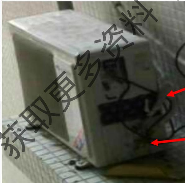
连接管触碰到外机面板，整条连接管绷的很紧，大小阀门处连接管无加油弯。
