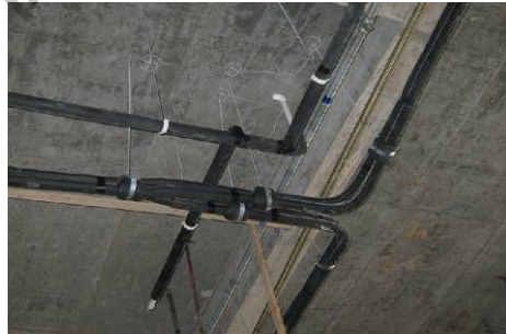
吊杆间距符合要求（正确） （间距在 1~1.5m）
