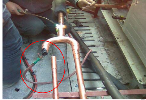
充氮气保护，避免产生氧化皮（正确）
