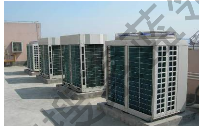
外机散热效果好（正确）
