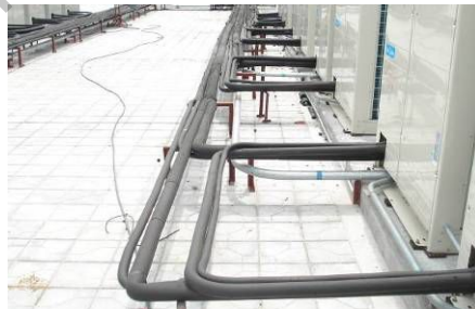
室外机分歧管安装规范（正确）
