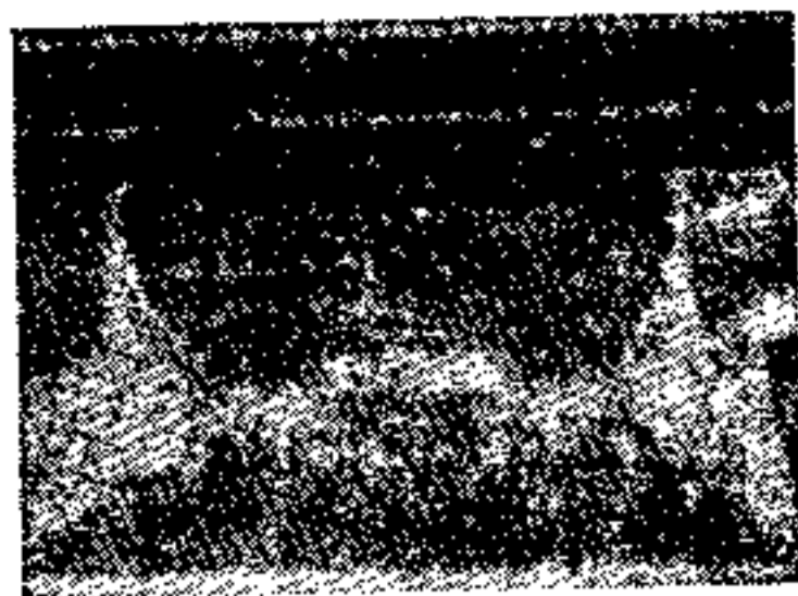
图26-23 姬路市民会馆 的观众厅照明 顶棚: 小型卤钨灯250W×83个墙 面: 小型卤钨灯150W×32个初期 平均照度260lx(观众席800)
