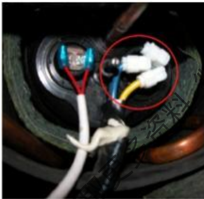
维修后压缩机线的连接
