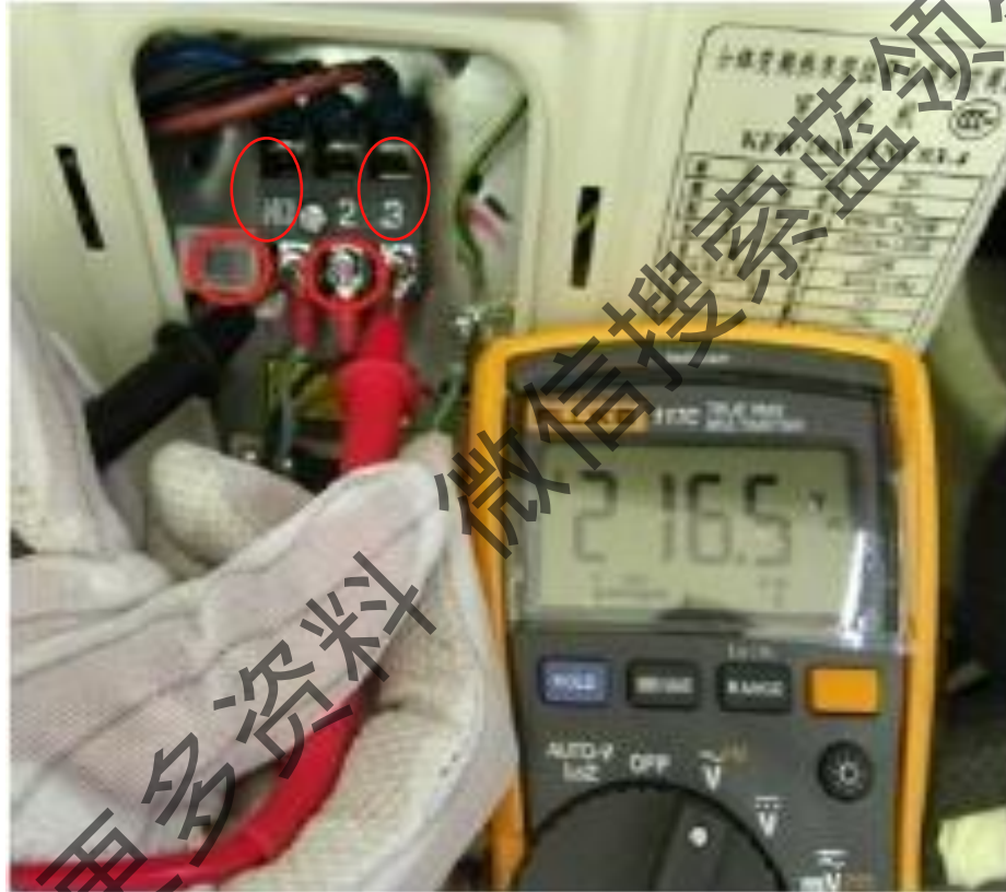
外机电源输入检测
