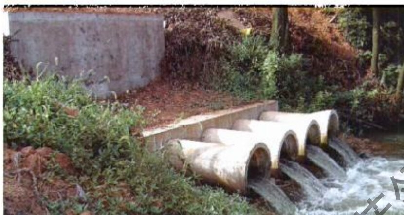
图2.5 开式地表水源热泵系统的排水口
