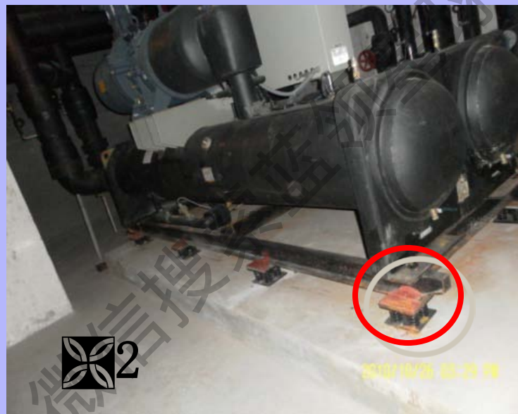
图1：无减震器和橡胶垫
