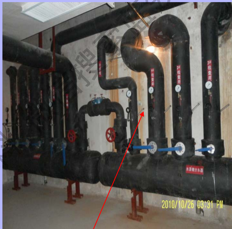
正确（压力表、标识方向、旁通阀）
