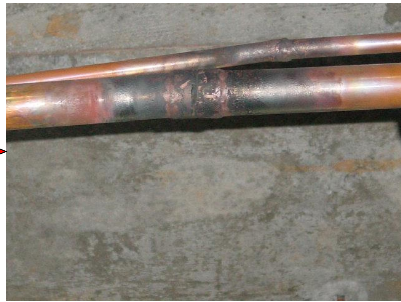
同管径胀管连接
